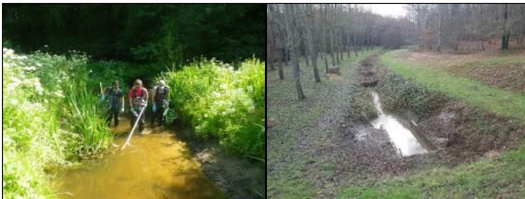
Figure 46 : Action de pêche électrique sur le Loc'h et mise en place de filtre à paille en amont d'une zone de travaux sur le Long
