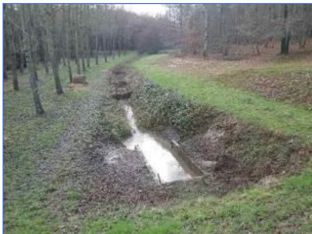
Figure 42 : Exemple de mise en place de bottes de paille dans le lit de la rivière le Long (37), à l'aval d'un étang lors de sa vidange
